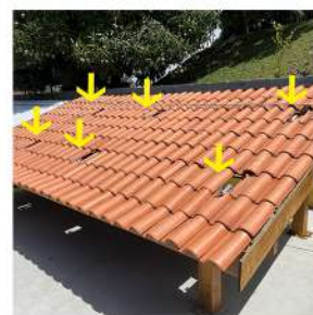
Figura 4 - telhado com ganchos
