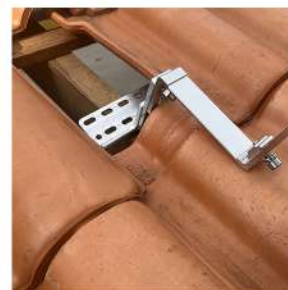
Figura 2 - Posicionar gancho
