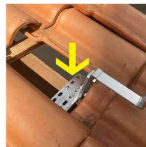
Figura 4 - gancho fixado
