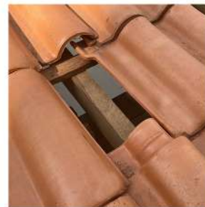
Figura 1 - Retirar telhas
