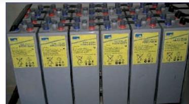
Fig. 1.24. Baterías de GEL. Vasos de 2 V.
