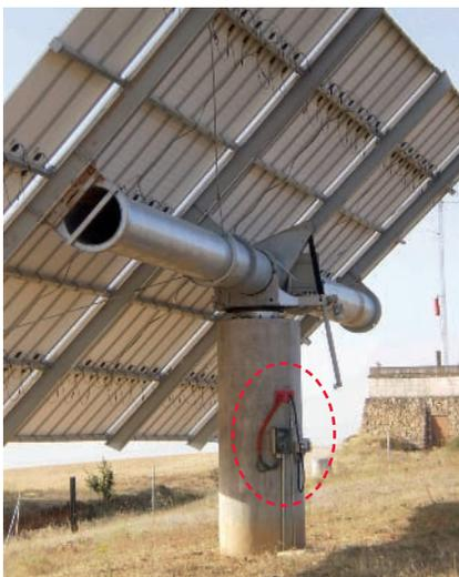
Fig. 1.17. Caja de conexiones de un módulo fotovoltaico.
