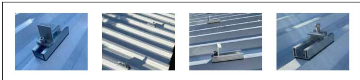
Figura - Fixação do minitrilho com painéis na horizontal e vertical
